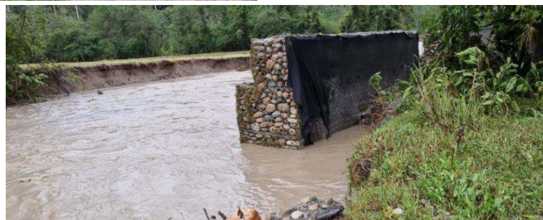
FIGURA N°01: TRAMO CRÍTICO EN EL CAUCE DEL RIO MOLINO, PRESENTA EROSION EN EN AMBAS MARGENES EN EL SECTOR MOLINOPAMPA, DISTRITO DE MOLINOPAMPA, PROVINCIA CHACHAPOYAS - AMAZONAS
